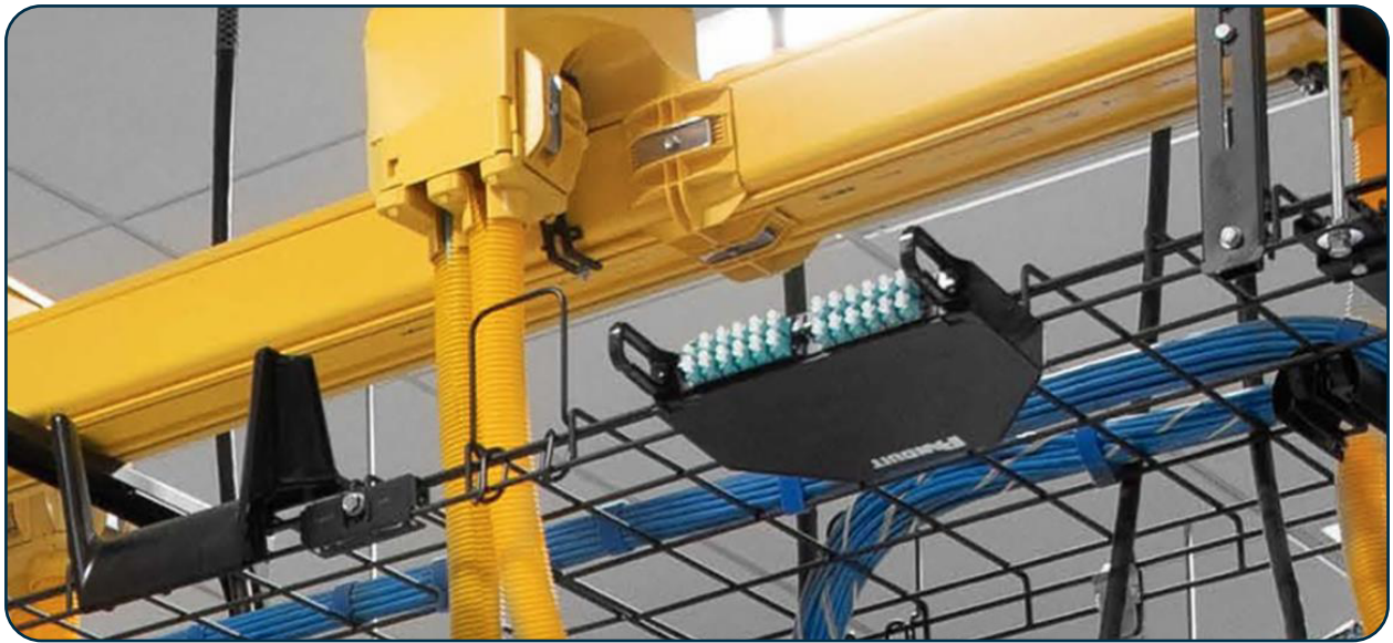
図 3. 設備および電気通信室の光ファイバーと銅線の経路
