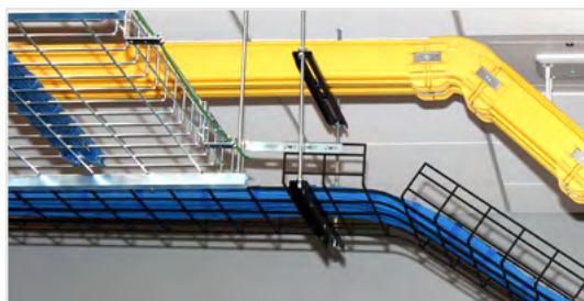
現場で垂直に高さ変更の加工をした上部と下部、および水平アングルの中央付近にサポートを設置
