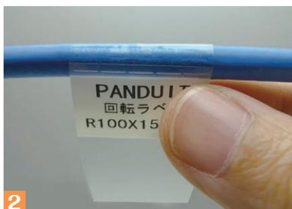
ラベル最上部の粘着部（アンカー）をケーブルに貼り付けます。その際、ケーブルに対し真っ直ぐにラベルを取り付けてください。
