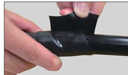
終端も電線外被覆（3cm分）を覆うようにして巻き仕上げ上げる。
