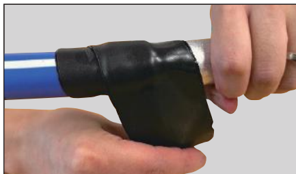
マスキングテープ幅の半分を目安に直線接続（銅側）へ重ねて巻く。
