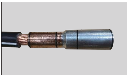
直線接続（銅側）に銅電線を挿入。
