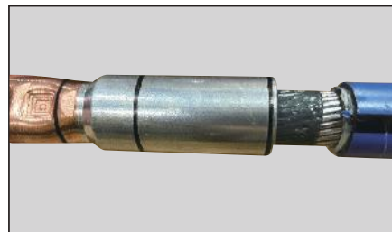
次に、直線接続（アルミ側）にアルミ電線を挿入。 コンパウンドが導体全体に塗布されている事を確認。
