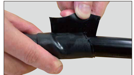
終端も電線外被覆（3cm分）を覆うようにして巻き仕上げるとよい。
