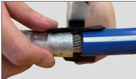
電線外被覆（3cm分）を覆いながら巻き付ける。
