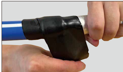
マスキングテープ幅の半分を目安に直線接続（銅側）へ重ねて巻く。引っ張らずに軽く巻き付ける。
