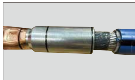
次に、直線接続（アルミ側）にアルミ電線を挿入。 コンパウンドが導体全体に塗布されている事を確認。
