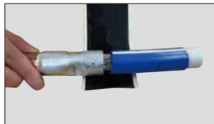
直接接続（アルミ側）からマスキングテープで絶縁、防水加工を実施。巻きの回数は1回でOK。
