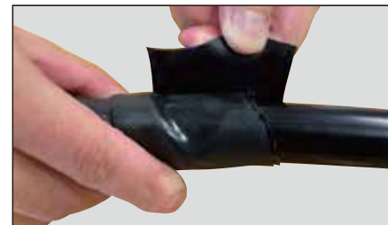
終端も電線外被覆（3cm分）を覆うようにして巻き仕上げる。
